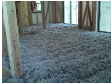
左上:壁吹き込み施工 右上:床吹き込み施工 左:天井裏吹き込み施工
